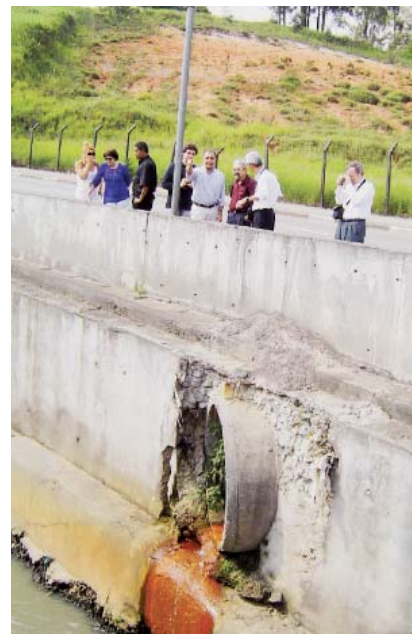
Visita à rede de drenagem pluvial em Santo André, São Paulo
