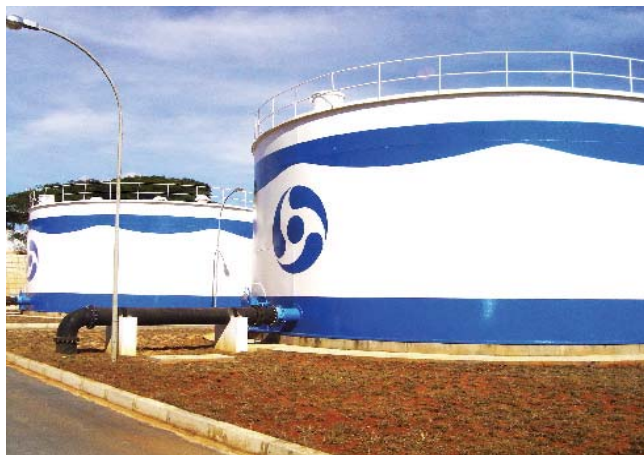
Reservatório da Caesb: parceria entre companhias estaduais, serviços municipais e escolas é um dos pontos fortes da rede.
