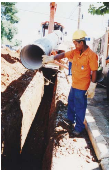
Rede de água em Guarulhos: capacitar técnicos de nível básico é um dos objetivos da ReCESA.
